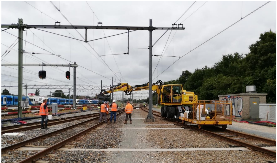
Inzet van een KROL (kraan op lorries) tijdens spoorwerkzaamheden.
